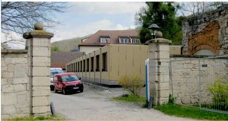
Aufbau der Interims-Fachkabinette für die Zeit der Schulhaus-Renovierung (Foto: Petra Mücke)
