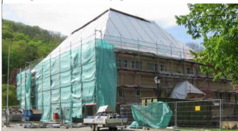
Baustelle Mühlengebäude, Frühjahr 2019
